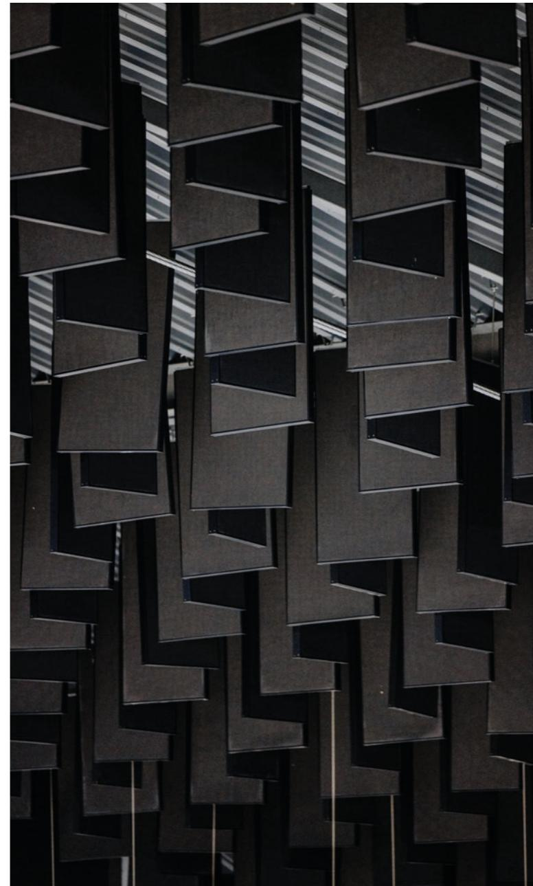
Dzięki wygłuszeniu ścian i montażowi specjalnych paneli, dźwięk w arenie roznosi się idealnie. Pod stropem umieszczono 16000 specjalnych paneli akustycznych.
